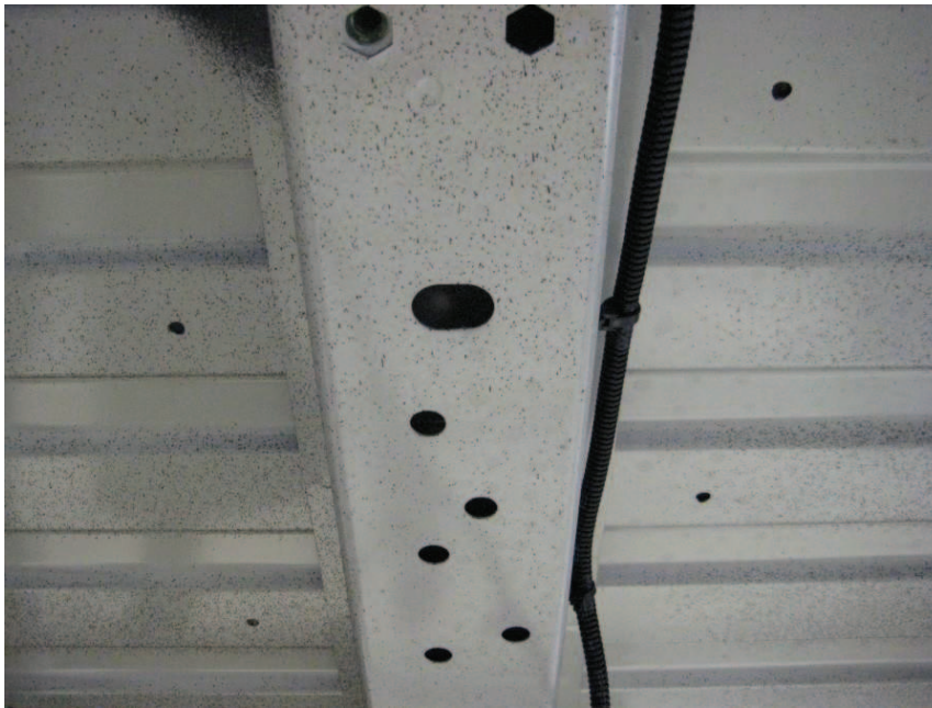
Löcher immer im Versatz bohren
