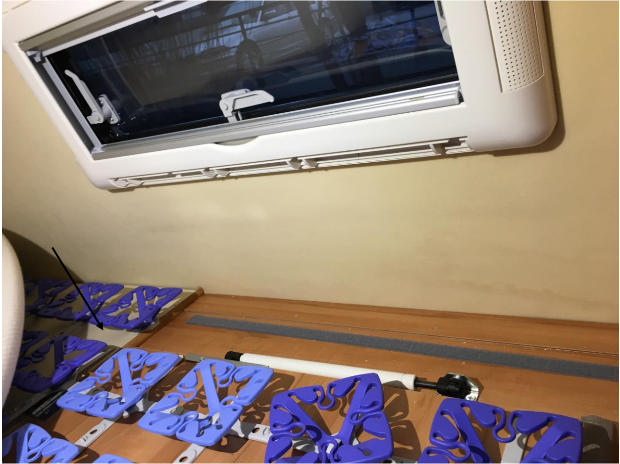
Sperrholz hat sich gewellt – ist nun wieder in einem akzeptablen Zustand zurückgegangen
